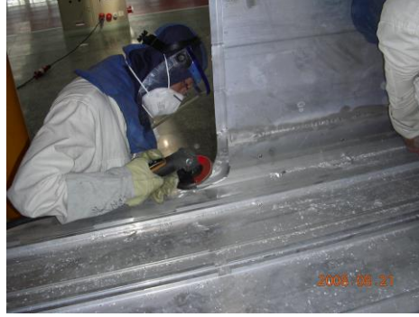
图 25-17 门角圆弧打磨示意图
