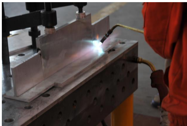
图 29—43 角焊缝试板的固定和预热过程
